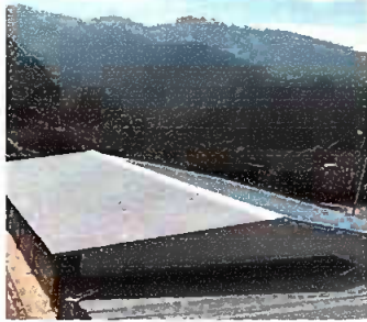
Foto1: Sustitución de lamina, por lamina troquelada aluzinc c- 26
