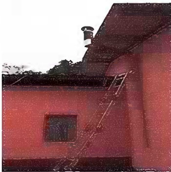
Foto 3: Sustitución de chimenea de metal por chimenea de concreto
