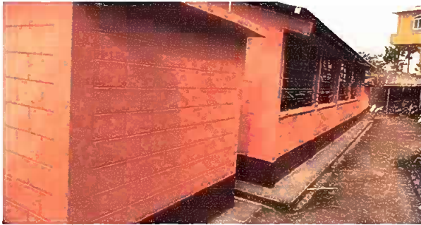
Foto1: Pintura en muros exteriores
