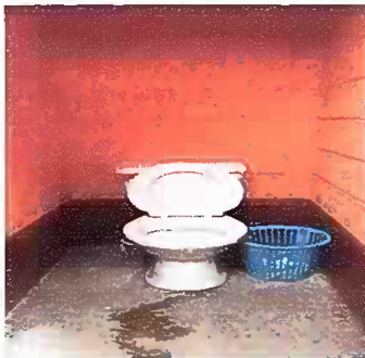
Foto 5: Reparación de baños
